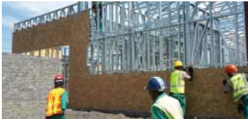
Sealtight Vaal – LWS Mini Warehouse
